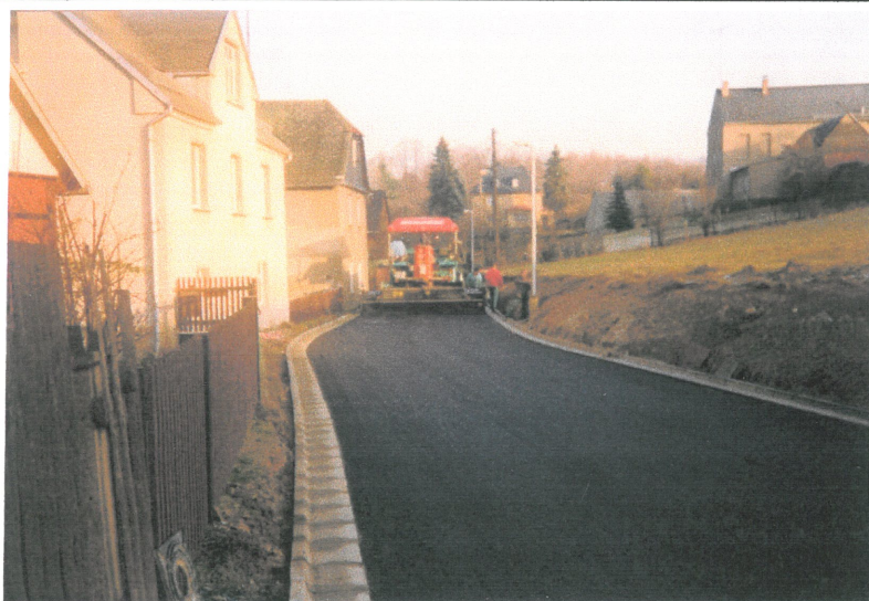
Eine Reihe notwendiger Straßenausbauarbeiten erfolgten in den 90iger Jahren im Ort.
