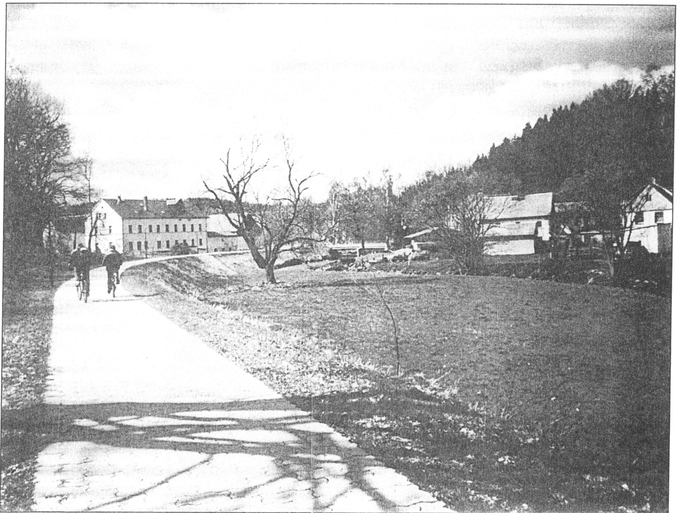
Teil des neuen Rad- und Wanderweges im Ortsbereich
