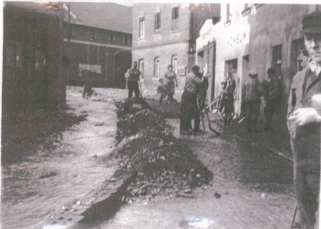
Aufräumen nach dem Hochwasser von 1954
